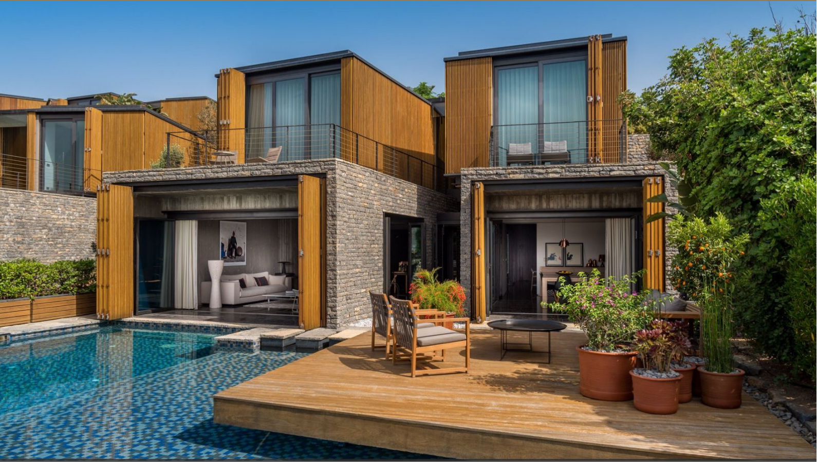
3050F cephe uygulaması
